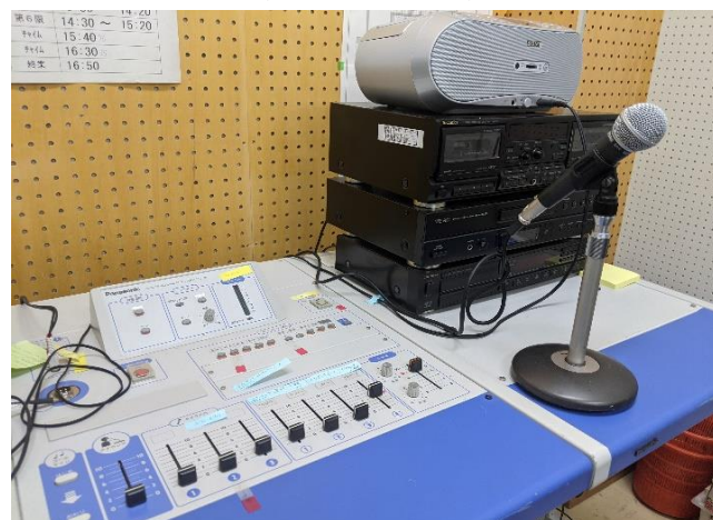
(放送室の機材)
